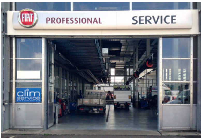
Die Nater AG punktet mit effizienten und kurzen Wartungs- und Reparaturzeiten.
