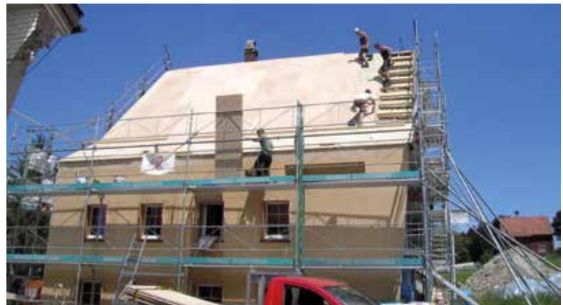
Schneider Wald, Dachsanierung, 2014
