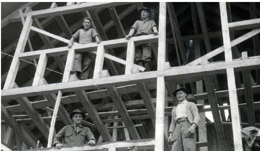
1945 legte Emil Höhener den Grundstein des Familienunternehmens – hier beim Aufbau der Mehrzweckhalle Wald, die heute noch im Einsatz steht.
